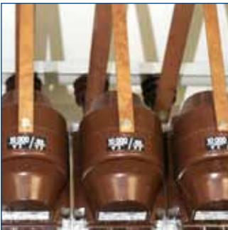
Das Voltage Interface Modul des SASensor kann an alle herkömmlichen Spannungswandler angeschlossen werden..
